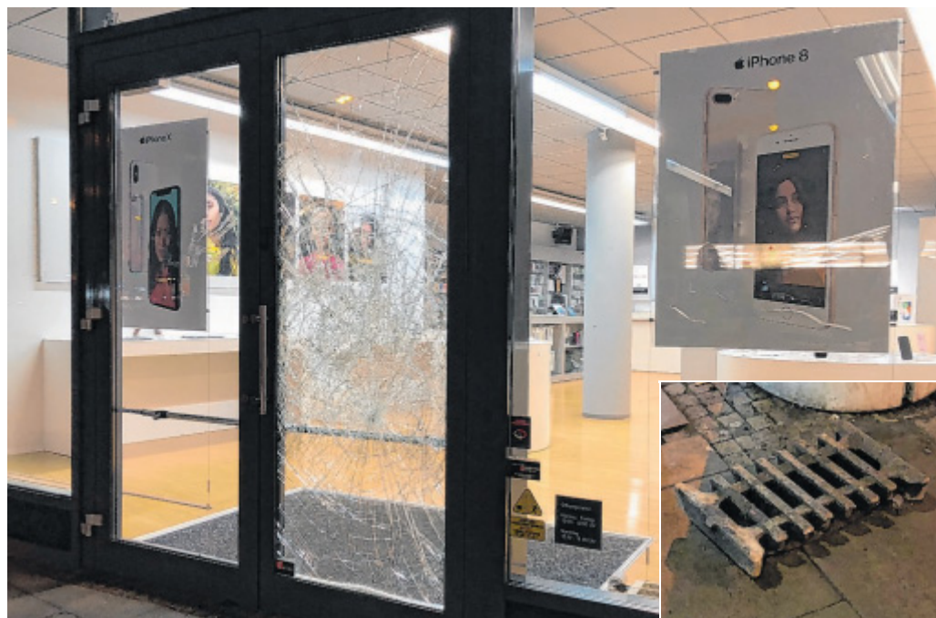
Schwer beschädigt: Mehrmals wuchteten die Unbekannten den Gullydeckel (r. unten) gegen die Glastür. Sie splitterte zwar, in die Räume gelangten die Täter aber nicht.
