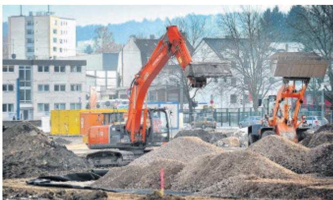
Baubeginn bei Oetker: Rechts neben den Baggern verläuft die Blücherstraße, hinter ihnen die Artur-Ladebeck-Straße. FOTO: ANDREAS FRÜCHT
