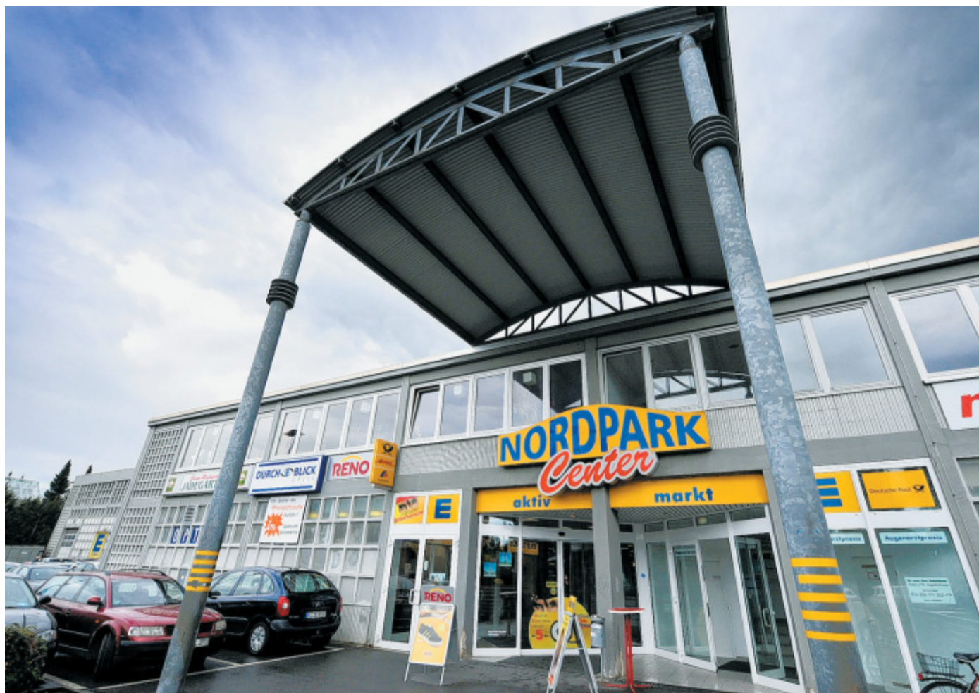
Komplette Umgestaltung: Das Einkaufszentrum an der Apfelstraße wird ab Herbst dieses Jahres renoviert. Die Belegung der Geschäfte ändert sich genau so wie die Lage des Haupteinganges.
