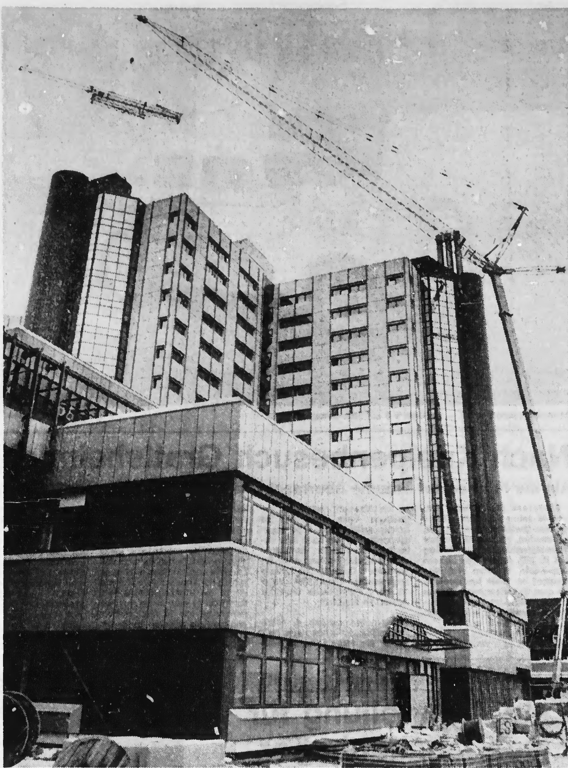
Ein riesiger Hebekran ist derzeit auf der Baustelle des Städtischen Krankenhauses im Einsatz. Das große Untergummi — es mißt 50 Meter und der Gittermast bringt es nochmal auf 56 Meter — soll vier kleinere Krane auf das Dach des Gebäudes hieven. Kein Problem, denn der Gigant kann bei einer Ausladung von einem Meter 300 Tonnen heben. ... und die vier kleinen wiegen jeder „nur“ 13 Tonnen. Wozu der Umstand? Hinter den vier roten Treppenschächten des Hochhausneubaus sollen jetzt die Be- und Entlüftungsröhre installiert werden. Und das geht nur von oben, schließlich ist jedes Rohrteil vier Meter lang und hat einen Durchmesser von 1,20 Meter. Der Riesenkran gehört zu den größten in der Bundesrepublik. Melnte Gerüstbauer Friedrich Kerhoff: „Im Bielefelder Raum dürfte das der erste Einsatz von der Güte sein, so was passiert hier in den nächsten 20 bis 30 Jahren nicht wieder.“ Natürlich wurde der Kran in Einzelteilen nach Bielefeld gebracht. In fünf Stunden war er wieder zusammengesetzt. Sein Einsatz bei der Montage und Demontage seiner „kleinen Brüder“ kostet allein zirka 60 000 Mark. Während der erste der kleineren Krane (unser Bild) — auch sie haben bei 20 Meter Ausladung immerhin eine Tragkraft von 650 Kilo — in zwei Teile zerlegt auf Dach gehoben wurde, trägt der Gigant die anderen „an einem Stück“ in die hohen Lüfte. Heute abend sollen drei Krane — fest verankert, damit sie eventuellen Stürmen trotzen können — montiert sein, der letzte kommt dann in einigen Wochen dazu.
