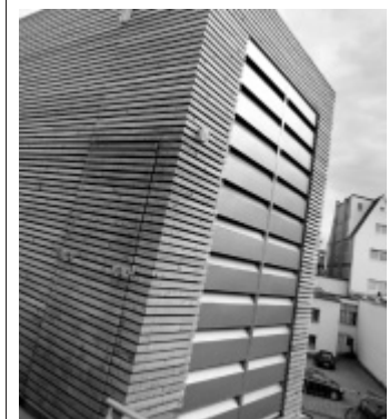
Lüftung des Anstoßes: Die Anlage im Hinterhof des Mantelhauses. FOTO: OLIVER KRATO
